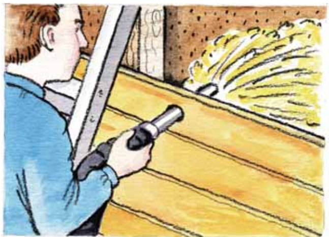
Innblåsing i eksisterende vegg
