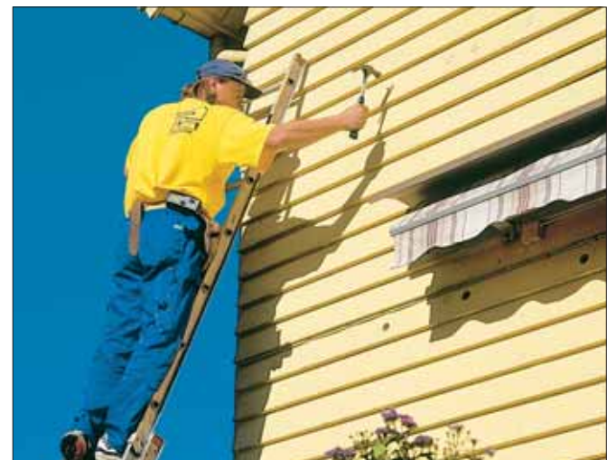
Plugging av hull med trespens
