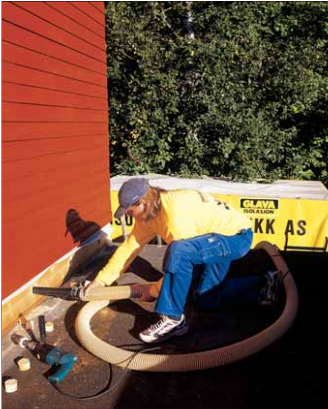
Innblåsing i eksisterende bjelkelag
