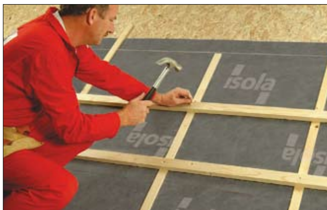
Filtene på produktets underside gir muligheter for fortløpende montering på hele taket. Sløyfer monteres umiddelbart. Isola Fugemasse skal benyttes ved detaljer og gjennomføringer.
