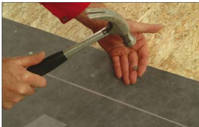
Stiftes siksak med c/c ca 10 cm i øvre omleggsfelt. Bruk galvanisert pappstift 2,8 x 25 mm. Skjules i omlegget.
