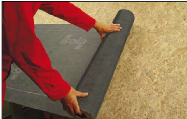
Horisontal utrulling ved takfot.
